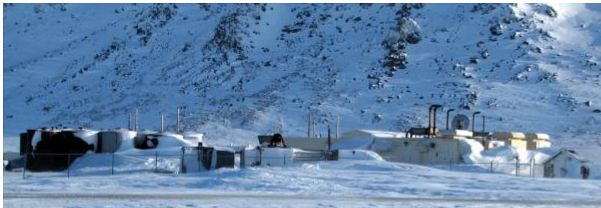
AVEC Power Plant and Tank Farm in Gambell
